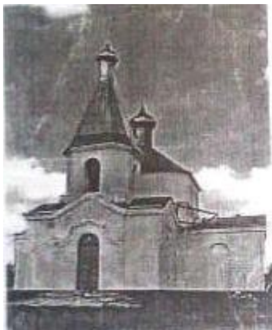
Фото 37. Церква в селі Явдотівка (Іоанно-Богословська церква – перша назва) (фото з музею)
